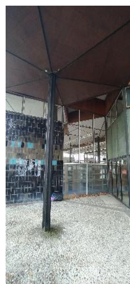
Poteau métallique intégrant une descente d'eau pluviale
